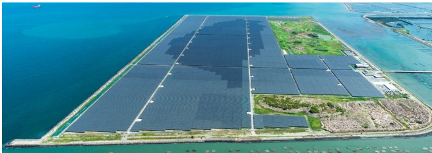
272 MW E2 Solar Project in Taiwan
